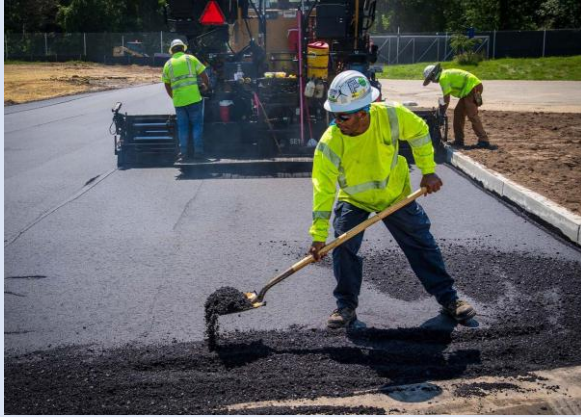
(شکل ۳-۵) اجرای روسازی آسفالتی
