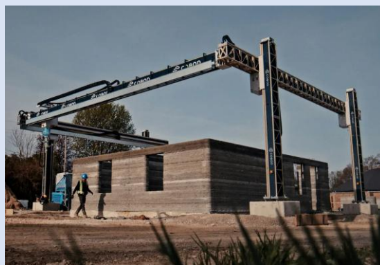
(شکل ۵-۱) ساخت با چاپگرهای دروازه‌ای
