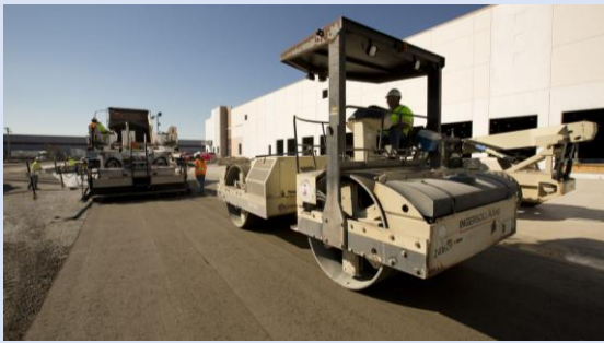
(شکل ۳-۴) اجرای روسازی بتن غلتکی
