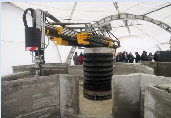
(شکل ۵-۲) ساخت با بازوهای رباتیک
