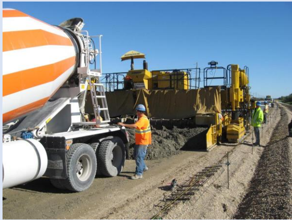
(شکل ۳-۶) اجرای روسازی بتنی
