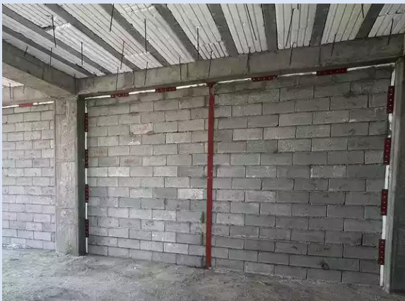
(شکل ۲-۸) نمونه ای از اجرا صحیح والپست
