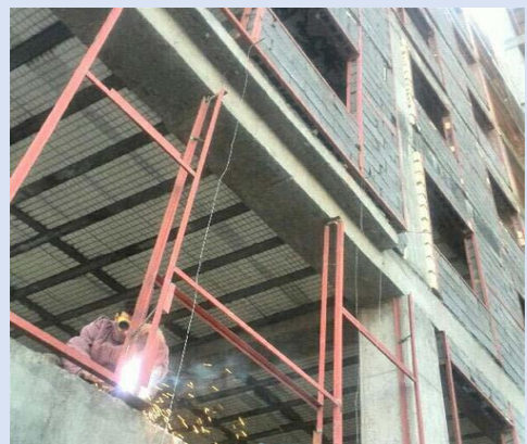
(شکل ۲-۲) نصب و اتصال اعضای والپست
