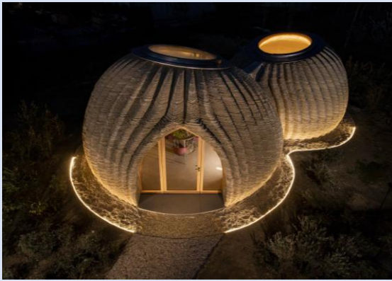
(شکل ۵-۵) پروژه TECLA در ایتالیا که به روش چاپ سه بعدی و با استفاده از خاک های محلی ساخته شده است
