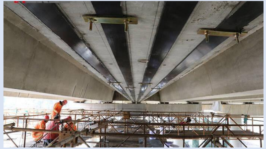
(شکل ۴-۴) مقایسه اجرای عملی مقاوم سازی تیر فولادی و بتنی پل با ورق‌های الیاف کربنی در یک پروژه واقعی
