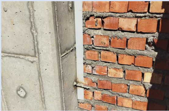
(شکل ۷-۲) نمونه عدم رعایت درز جداسازی
