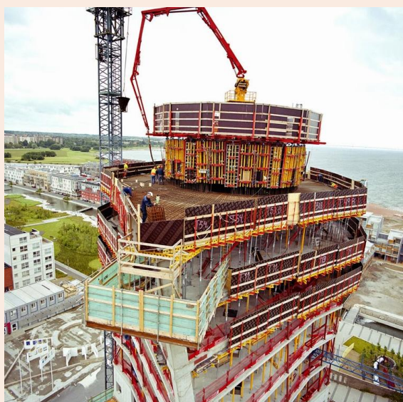
(شکل ۲-۱) بتن ریزی هسته و دال بتنی سازه
