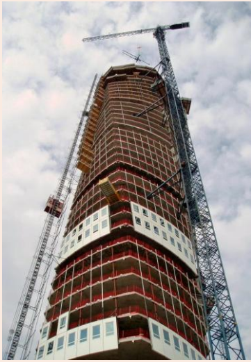
(شکل ۷-۱) اجرای نمای برج
