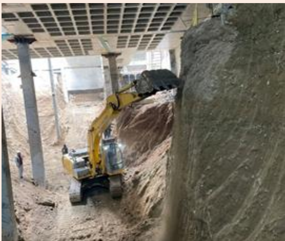
(شکل ۴-۴) اجرای خاکبرداری مرحله‌ای طبقات زیرین
