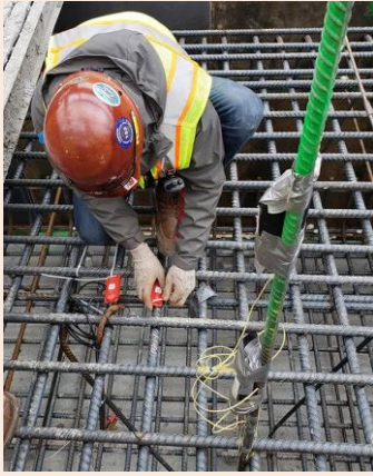
(شکل ۲-۳) نصب اجزای دستگاه مدل سازی حرارتی بتن
