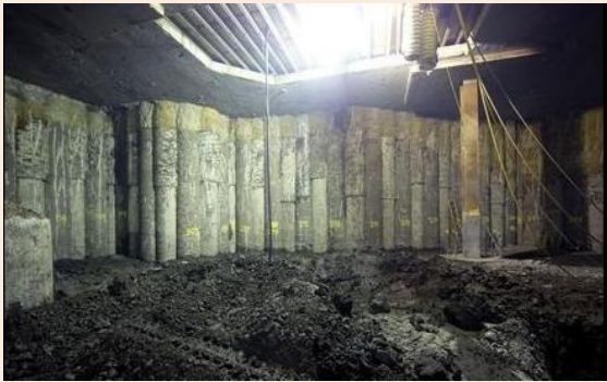
(شکل ۴-۶) اجرای دیوار دیافراگمی و شمع‌ها در برج شاردر
